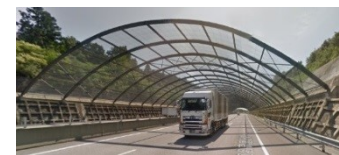
GPS精度低下区間の例（金属ネット）
